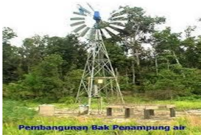
Gambar 1. Pembangunan Bak penampung air dari kincir angin Sumber : pompa-kincir-angin.blogspot.com
